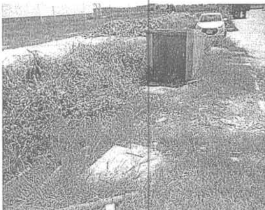
Foto 1. Área donde se encuentra la fosa séptica que recibe las aguas residuales domésticas provenientes de los baños de la empresa Steckerl Aceros S.A.S.
